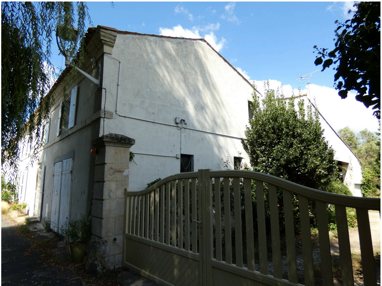
Le logis et l'ancienne grange à l'arrière, vus depuis le sud-est.
