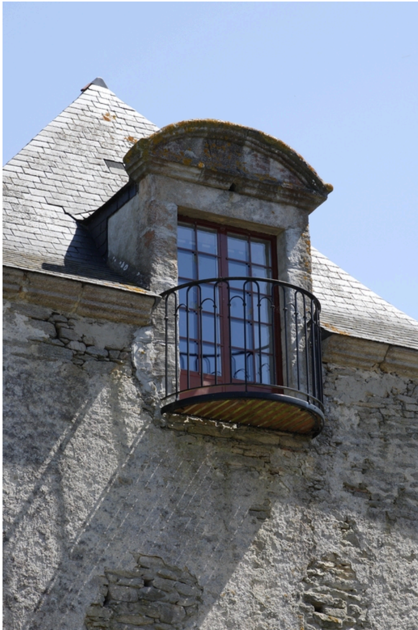
Logis. Détail de la lucarne du pignon ouest.
