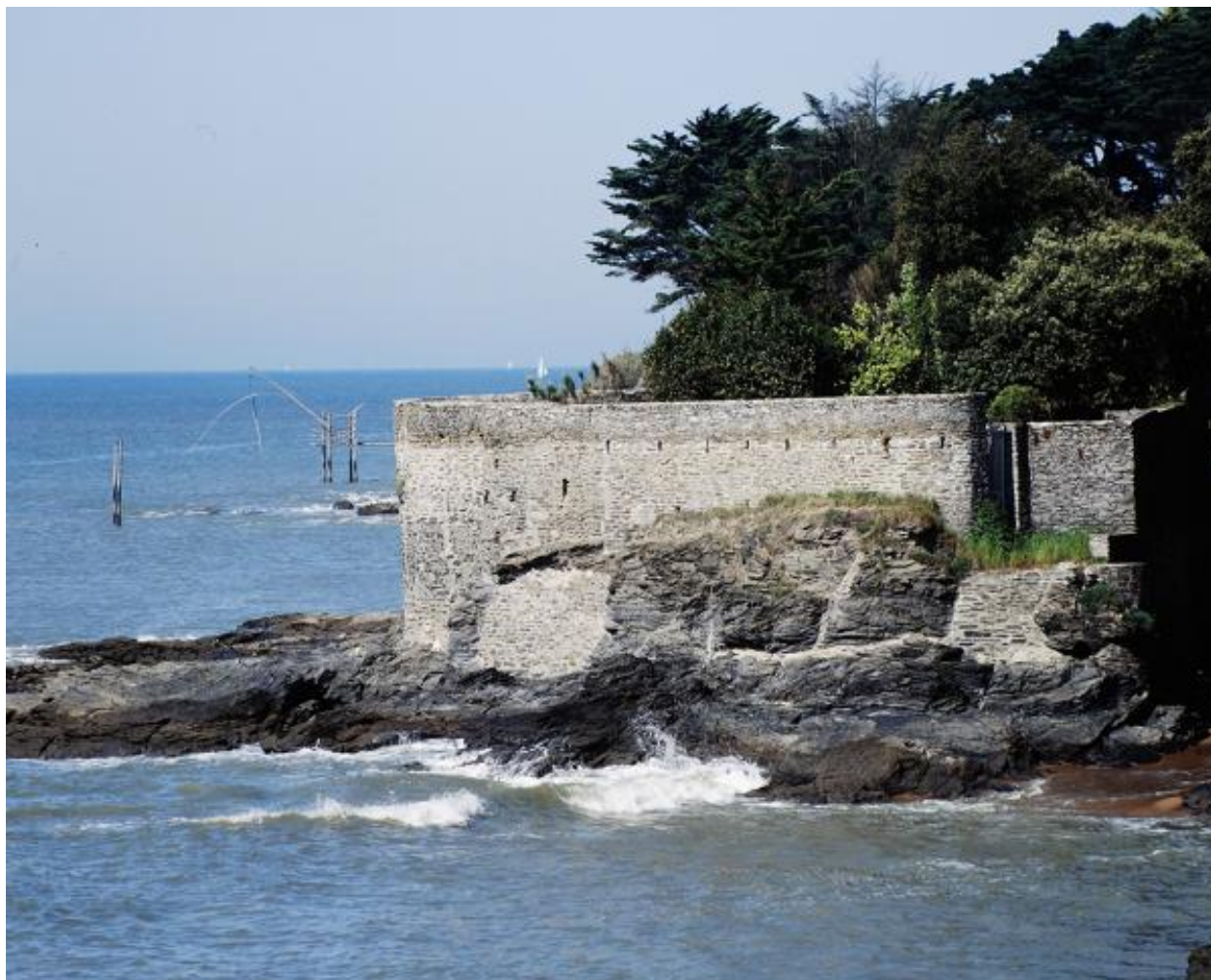
Murs de soutènement surplombant la côte.
