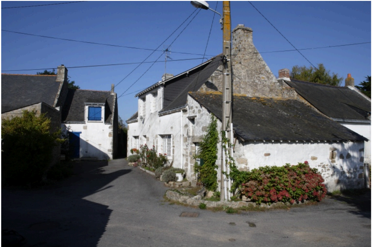
Vue d'ensemble de la rangée depuis le sud-est.
