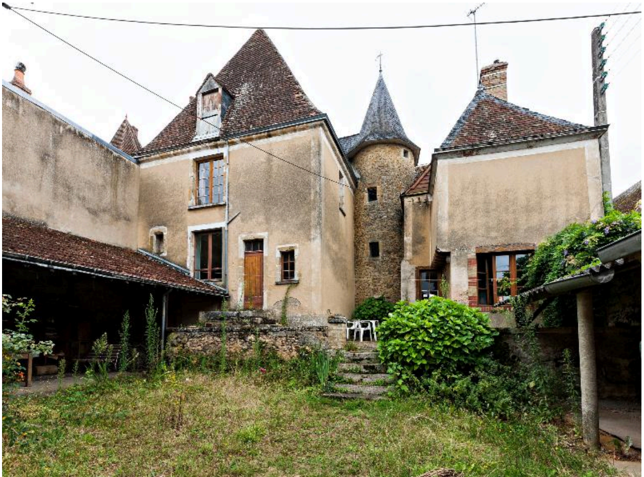
Elévations postérieure de la maison n° 14.
