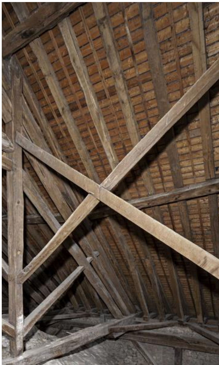
Vue d'une travée de la charpente avec une croix de Saint-André.
