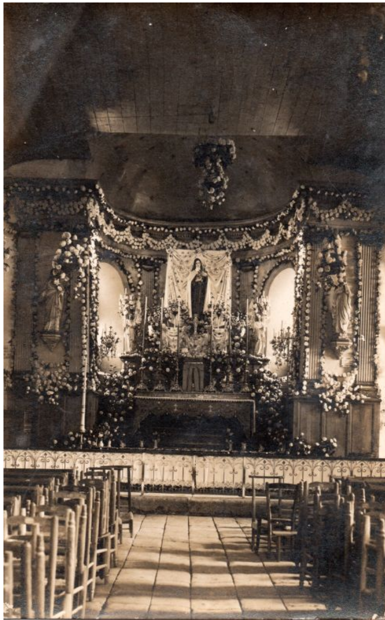
Vue du chœur en 1927 sur laquelle on aperçoit le semis d'étoiles sur la voûte.
