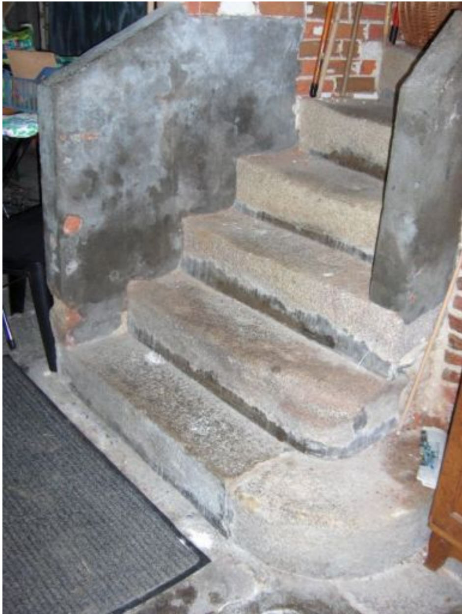
Escalier en granite du sous-sol.
