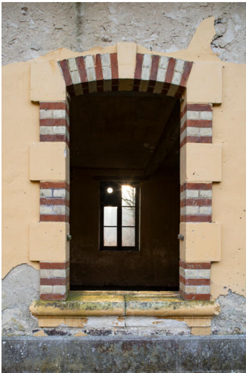
Détail d'une baie des communs.
