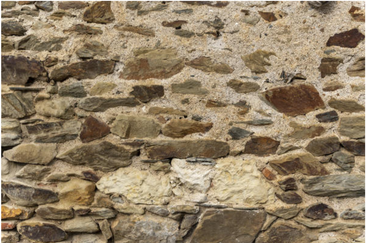
Un détail de la maçonnerie.
