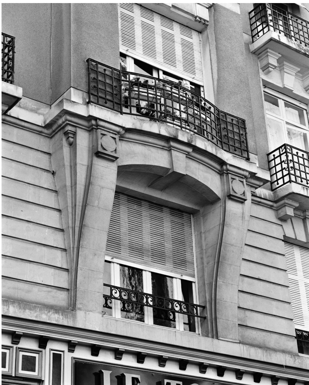
Elévation antérieure, avant-corps droit : baies des 2e et 3e niveaux.
