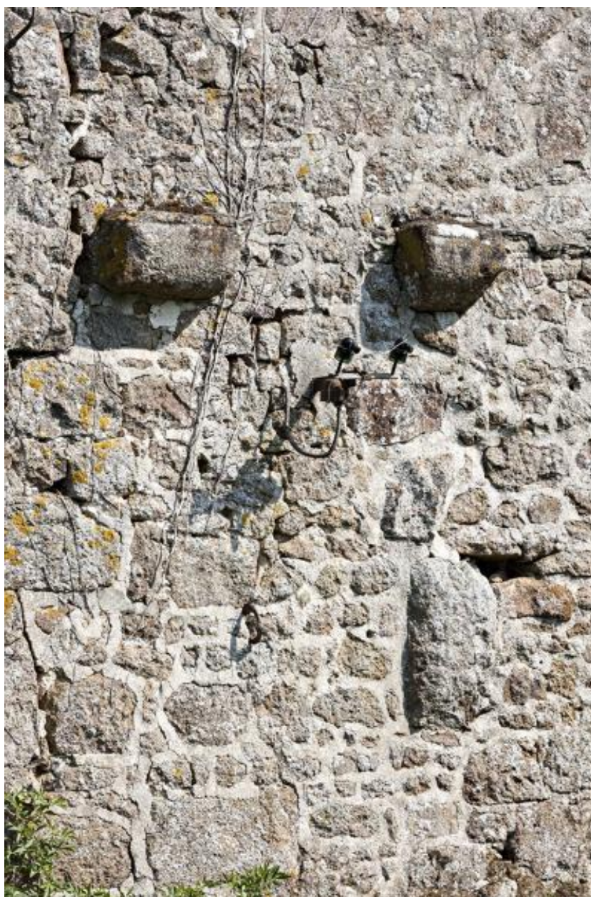
Mur-pignon sud du manoir.
