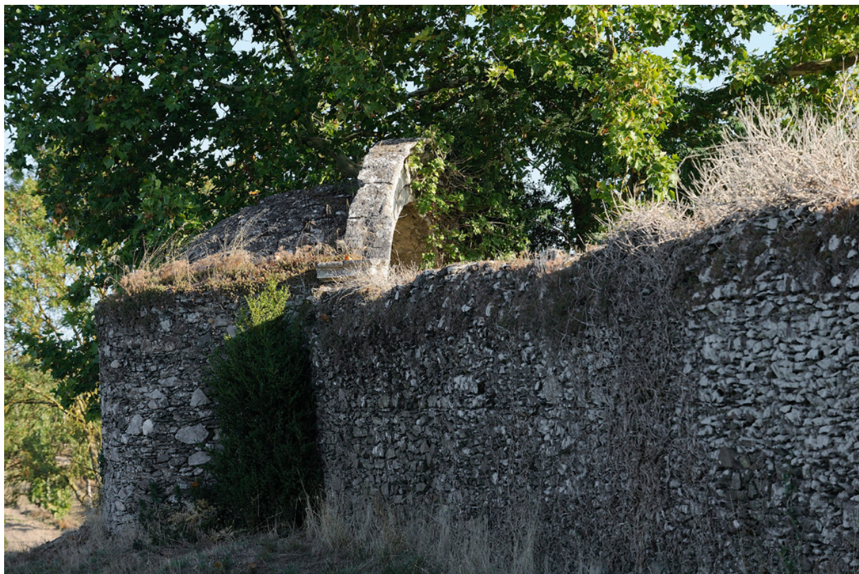
Cabane viticole en pierre s'appauyant sur un mur de clôture.
