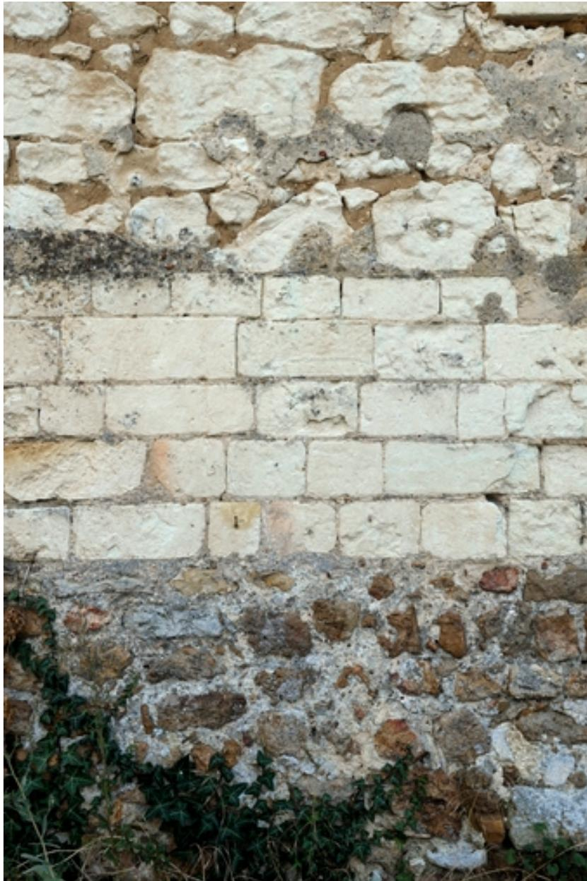
Hôpital, aile nord (rue des Moulins). Détail de la maçonnerie : moellons de perrons, petit appareil de tuffeau, moellons de tuffeau.
