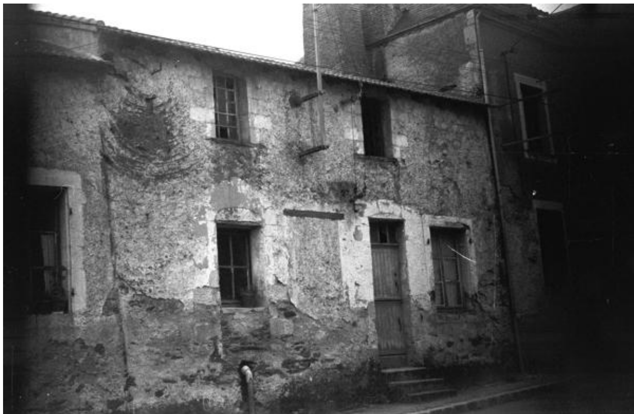
Façade principale, maison sur rue, partie ouest, 3 rue de la Houssaye, Saint-Laurent-du-Mottay.
