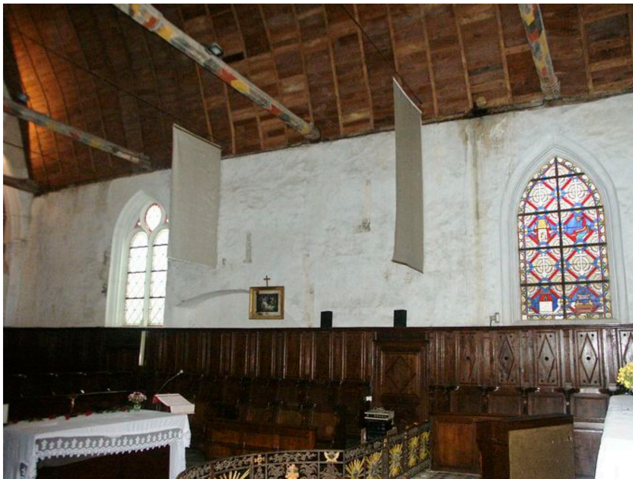
Chœur, mur nord : fenêtres de sondages.
