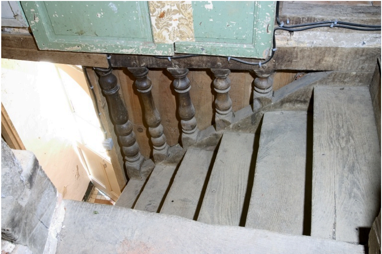
Intérieur du logis : l'escalier vu depuis le comble.
