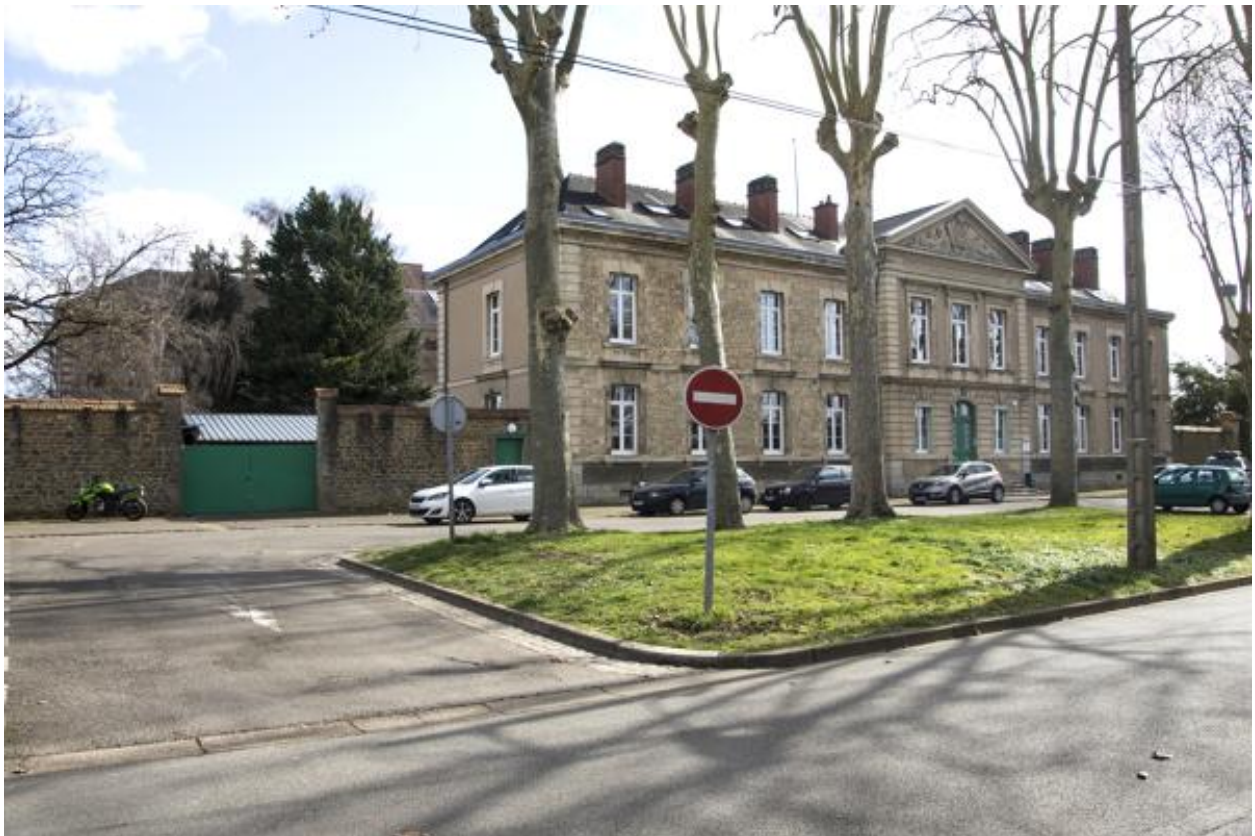
Vue du bâtiment de la caserne donnant rue des Résistants Internés depuis la rue.
