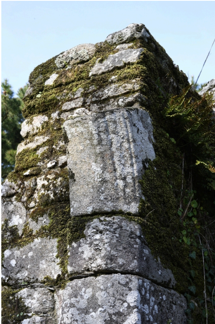
Portail d'entrée. Détail de la moulure de la porte charretière.
