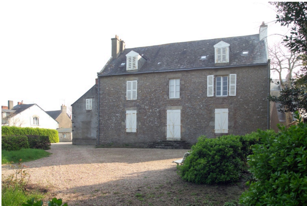
Vue de la façade sur jardin vers l'Est.
