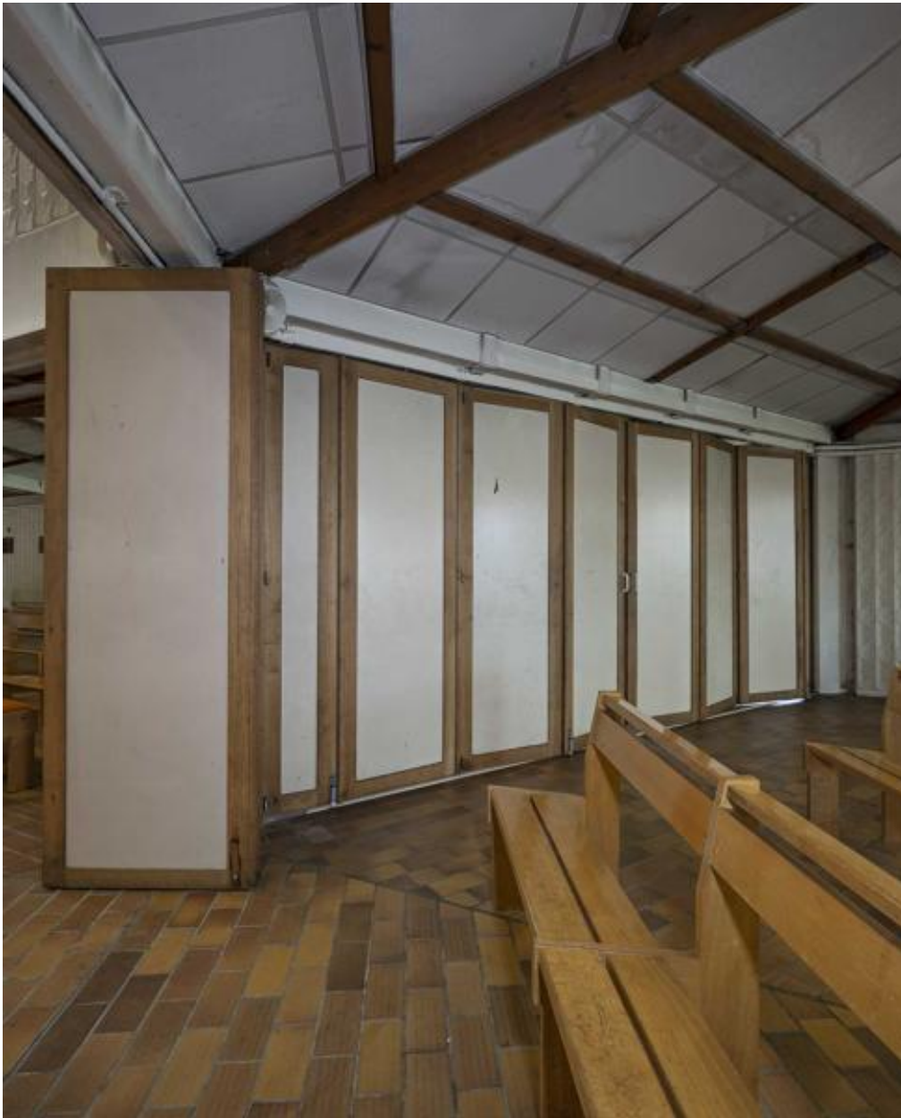
Vue d'une cloison mobile fermée.
