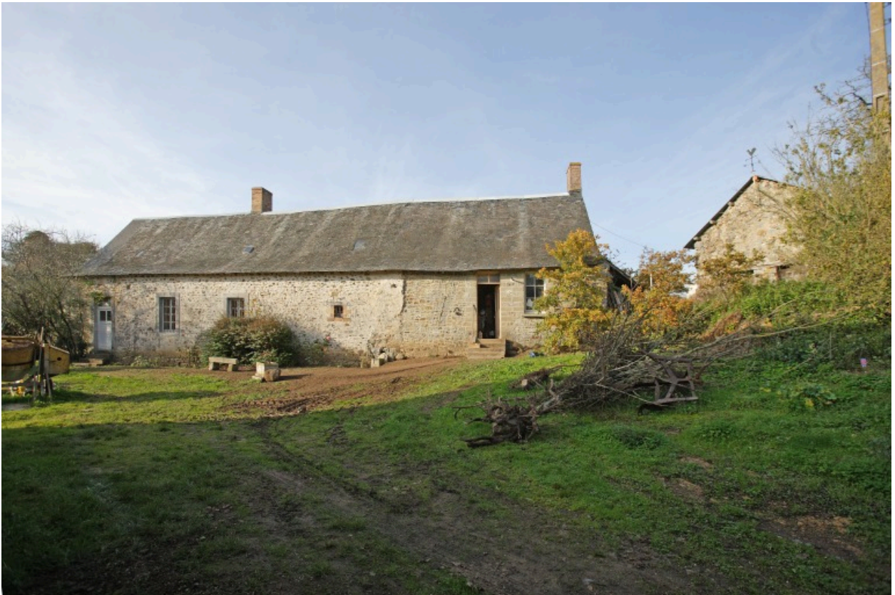
Le logis et la porcherie vus depuis la cour au sud-est.
