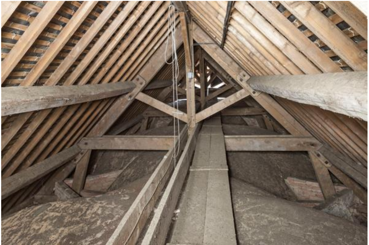
Charpente de l'église du Housseau.
