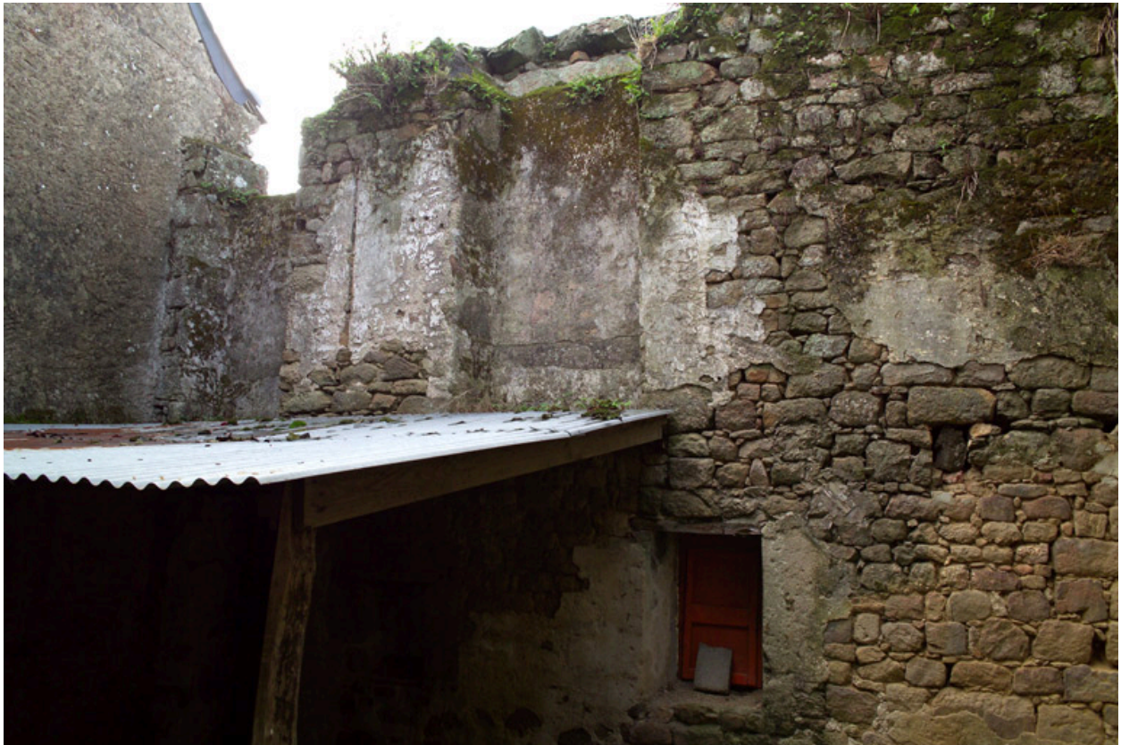
Aile sud, revers de la façade sud, portion ouest.
