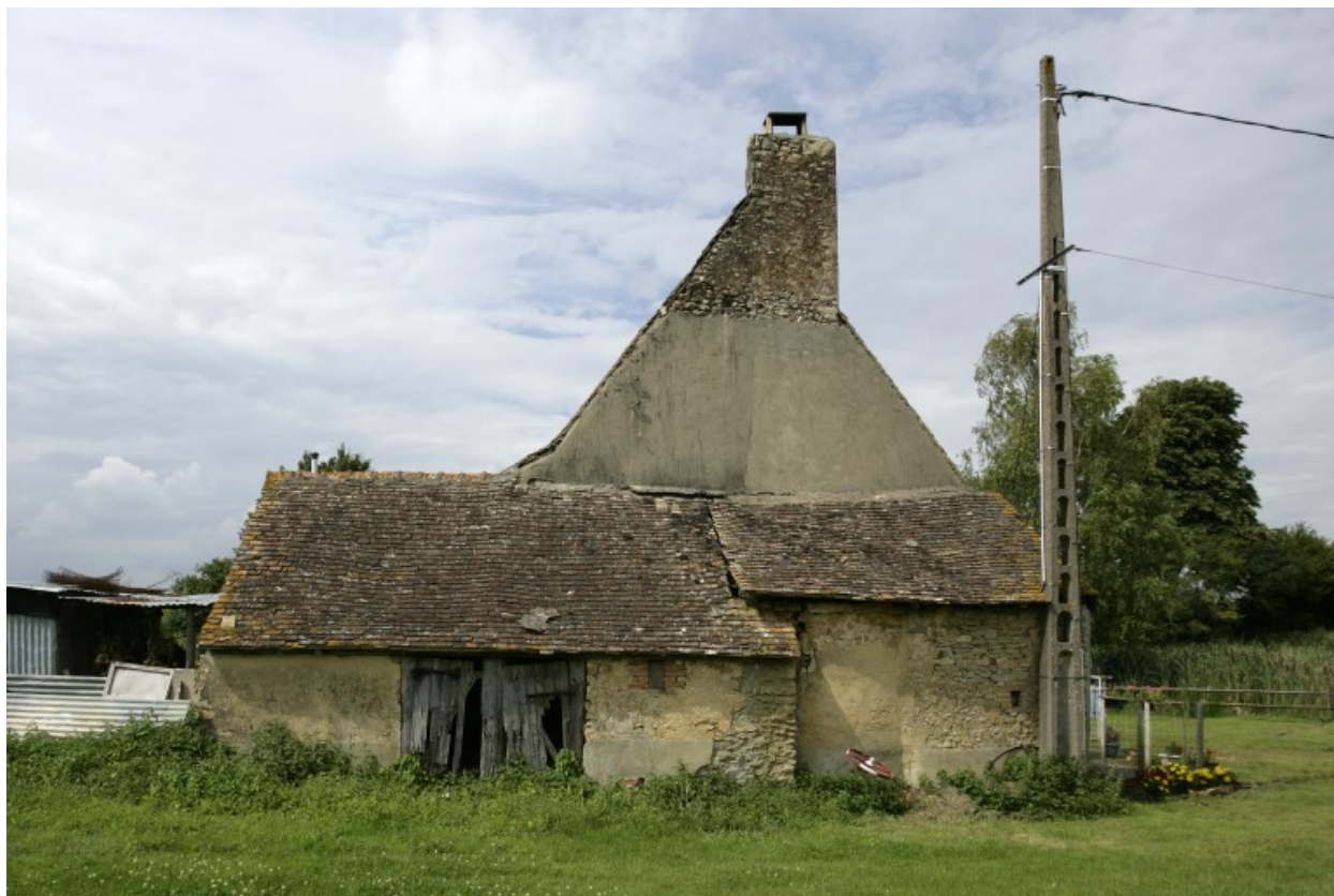
Logis, pignon à cheminée avec toits à porcs.
