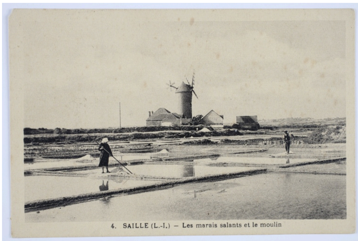
4. Saillé (Loire-Inférieure) - Les marais salants et le moulin. Vue lointaine du moulin, équipé de ses ailes Berton et de son moulinet d'orientation.
