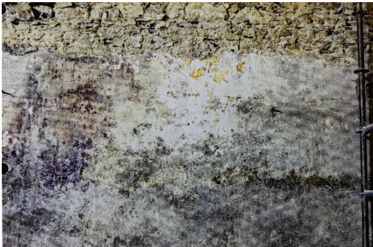
Chœur, collatéral extérieur, mur sud, vue de détail : vestiges de peintures murales.
