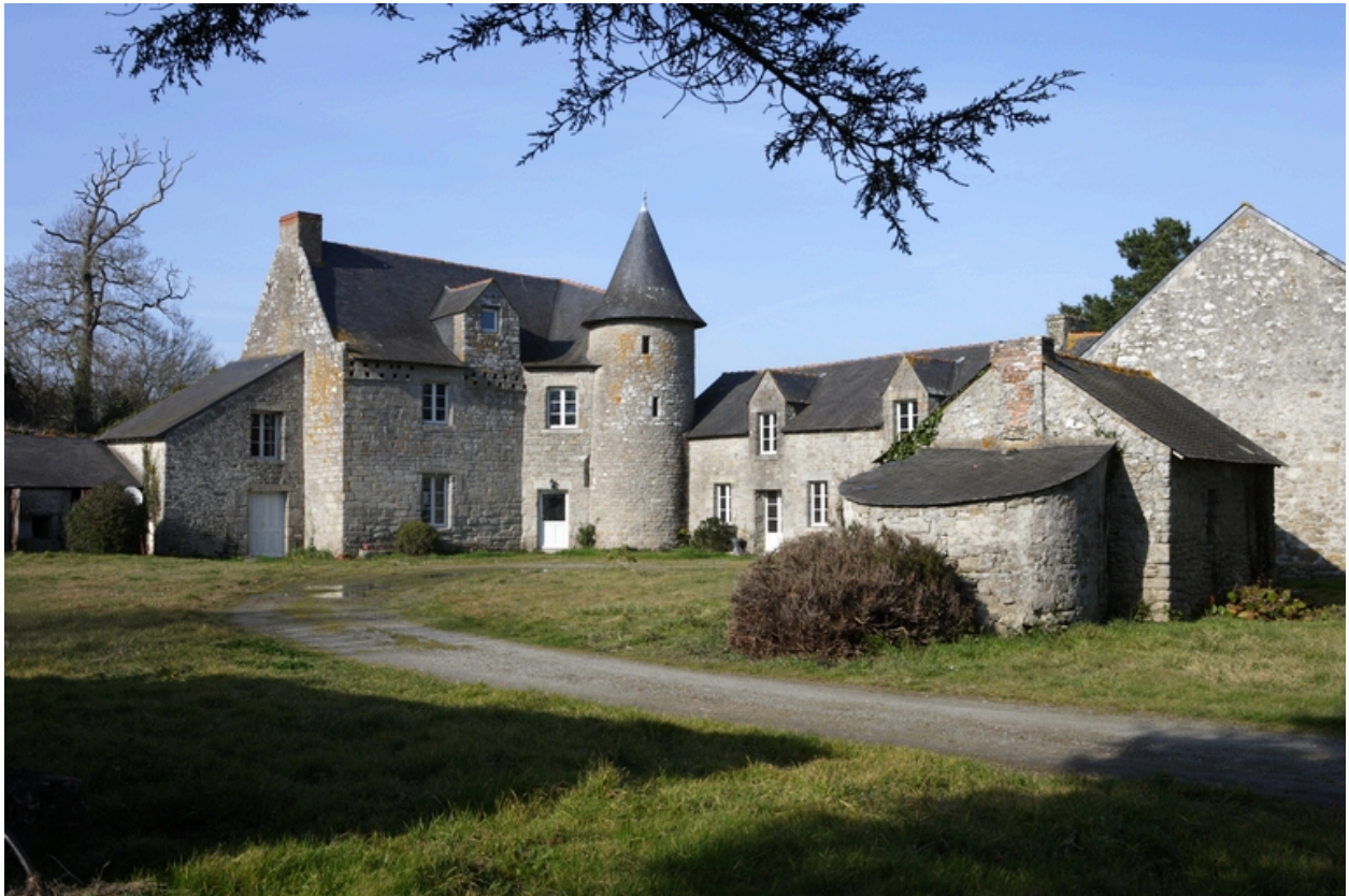
Vue d'ensemble depuis le sud.
