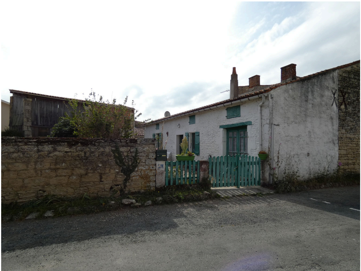
Le logis vu depuis le nord-ouest.
