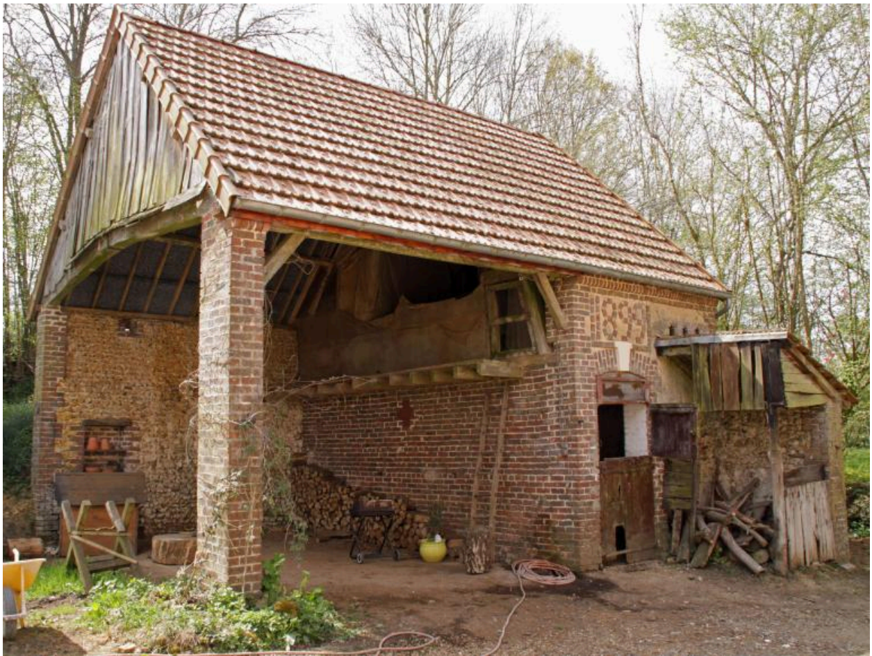
Hangar agricole et écurie à chaînages de brique (1899). La Goualonnaière.
