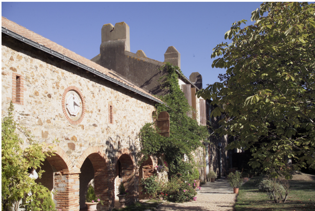
Vue partielle des façades sur le jardin.
