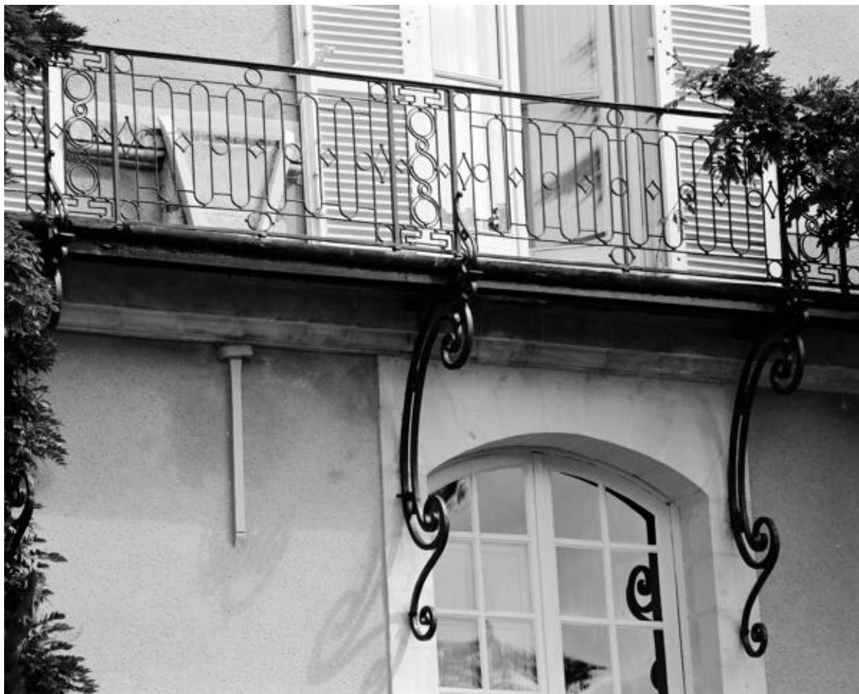
Aile sud de l'abbaye, élévation sud, sur le jardin : détail sur le balcon du premier étage.
