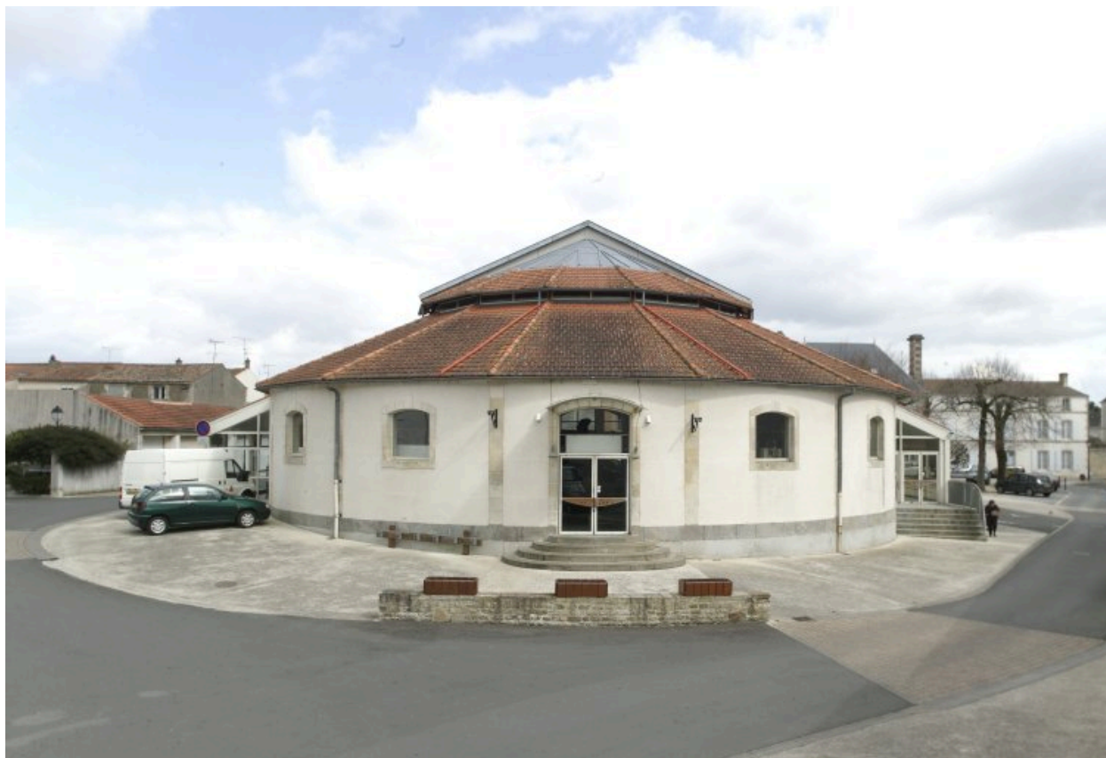
Vue de la partie arrière de la halle, en héli-cycle, prise de l'ouest.
