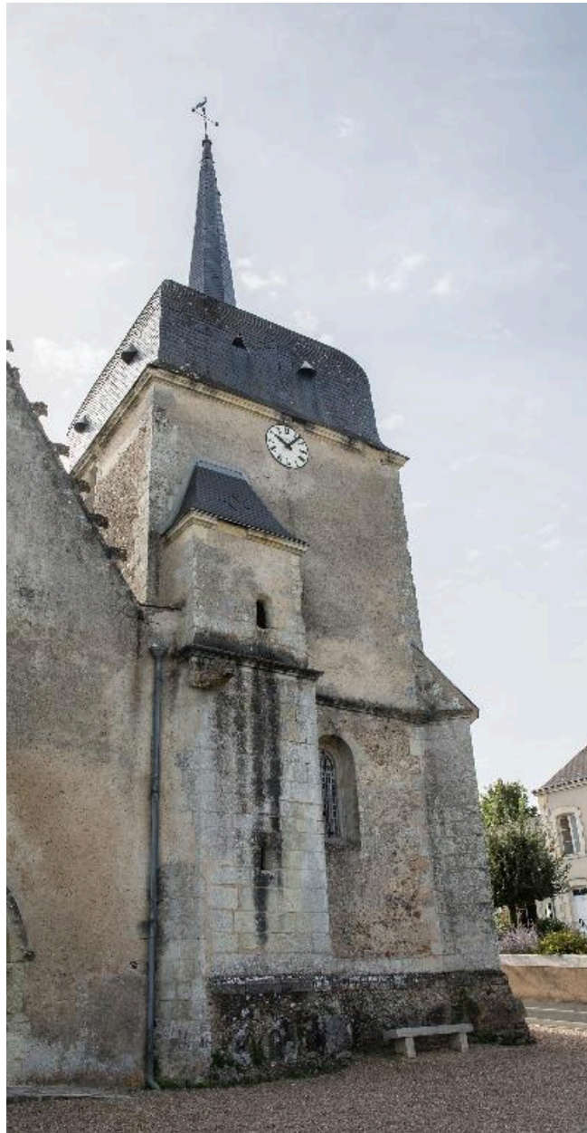
Tour-clocher logeant la chapelle sud 1.
