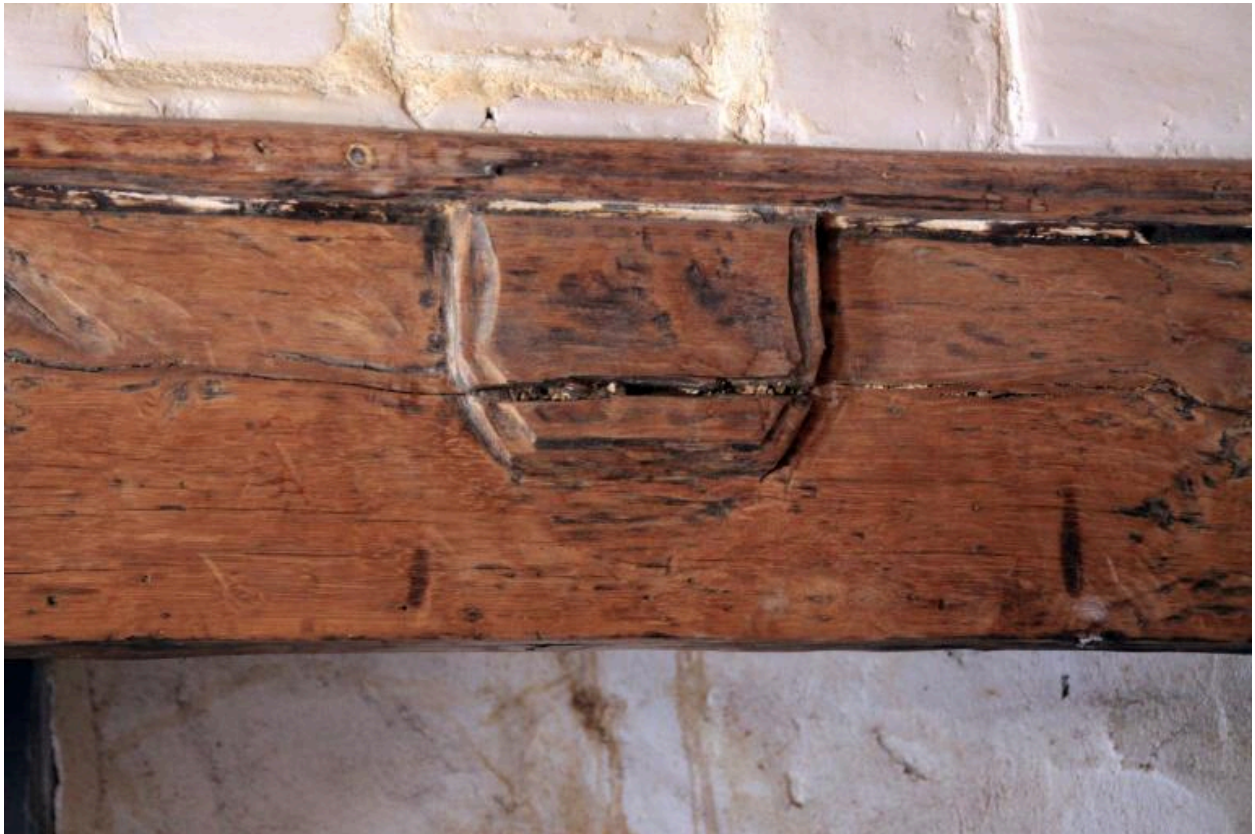
Logis, rez-de-chaussée, chambre à feu : détail de l'écusson sur le linteau de la cheminée.
