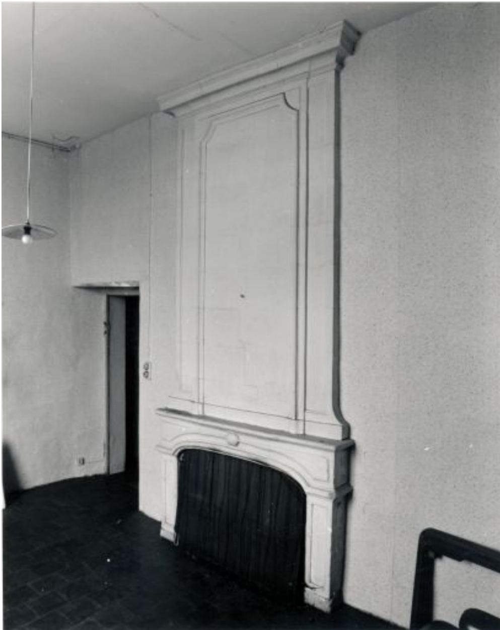
Bâtiment des écuries, rez-de-chaussée, pièce d'habitation droite, mur latéral gauche : cheminée.
