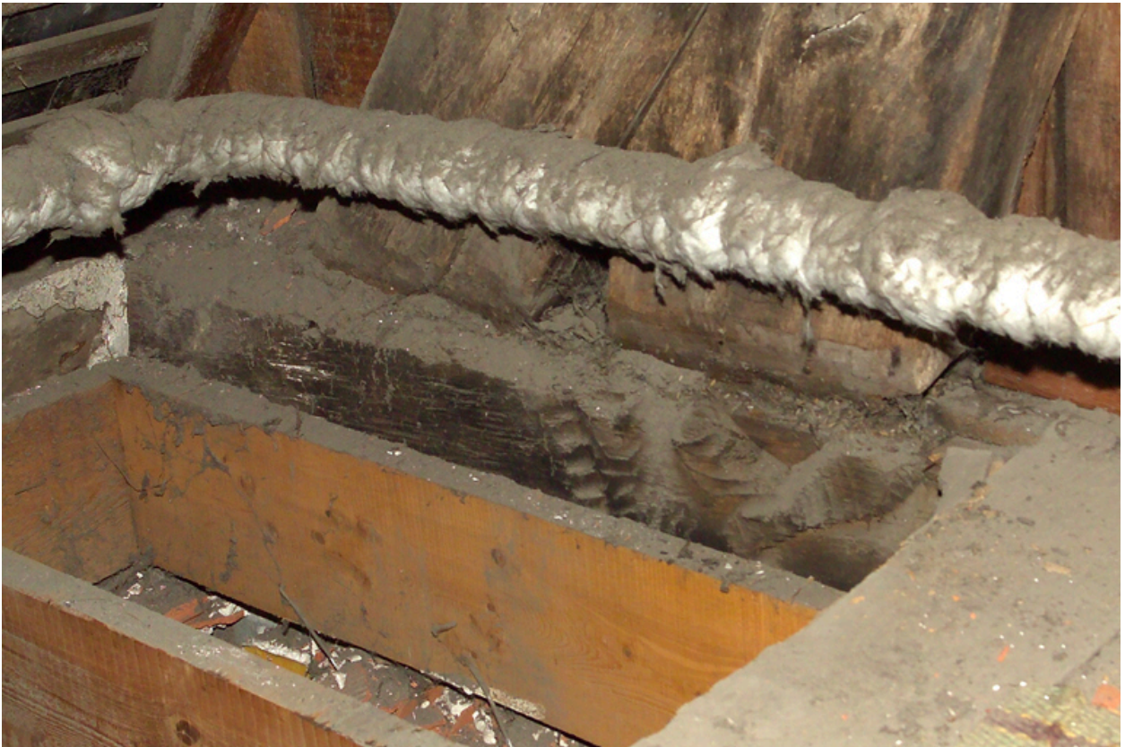
Détail de l'engoulant nord de la seconde ferme en partant de l'ouest.
