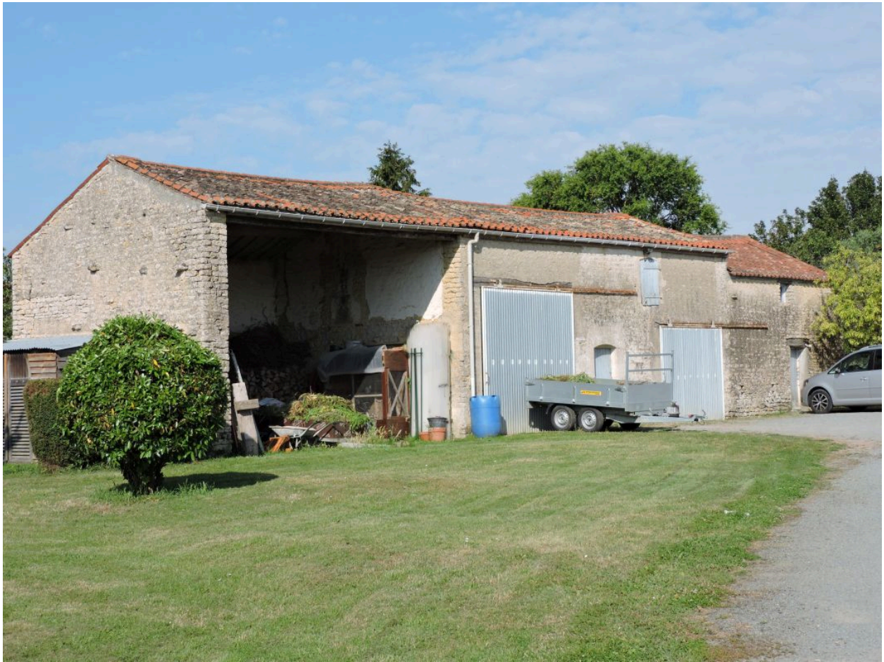
Le hangar et l'ancien logement, au sud-ouest de la cour, vus depuis l'est.
