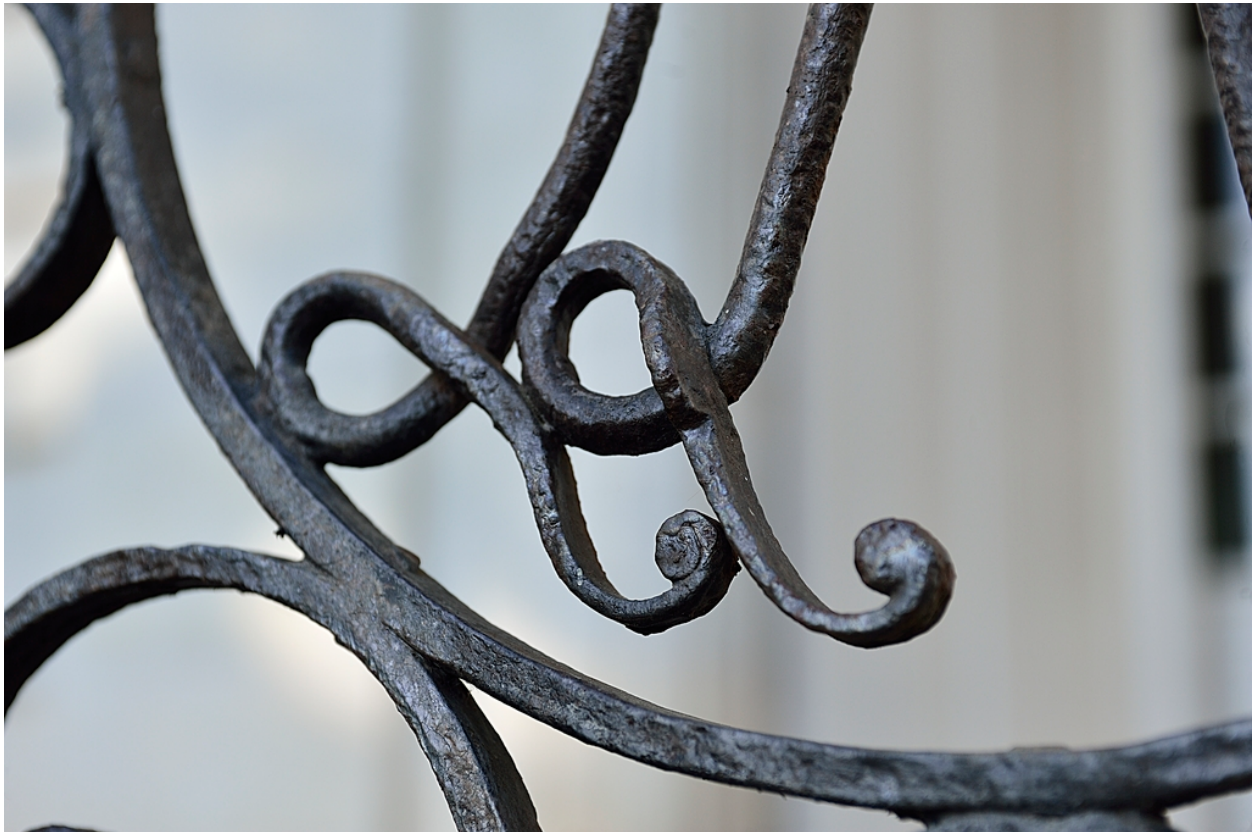
Détail du balcon en fer forgé.
