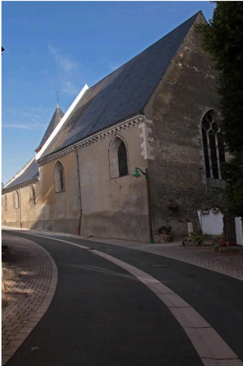
Vue de volume du chœur prise depuis le sud-est.
