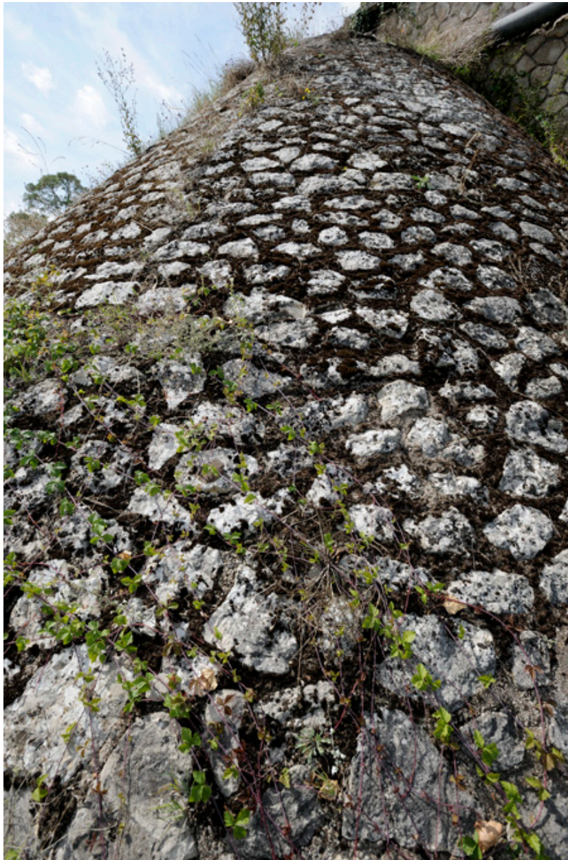
Levée d'accès à l'entrée sud du pont
