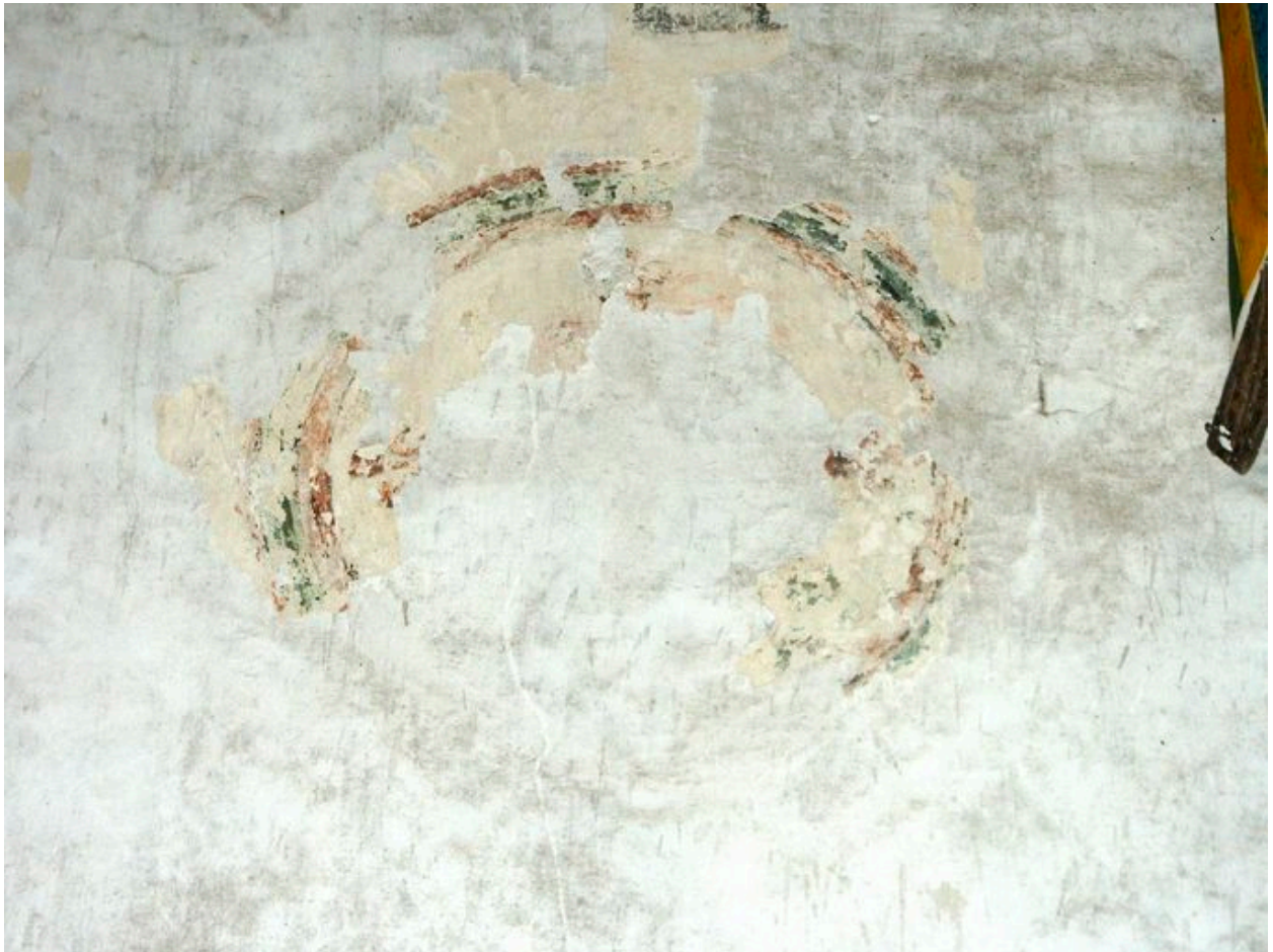
Chœur, mur nord : croix de consécration partiellement dégagée des badigeons.
