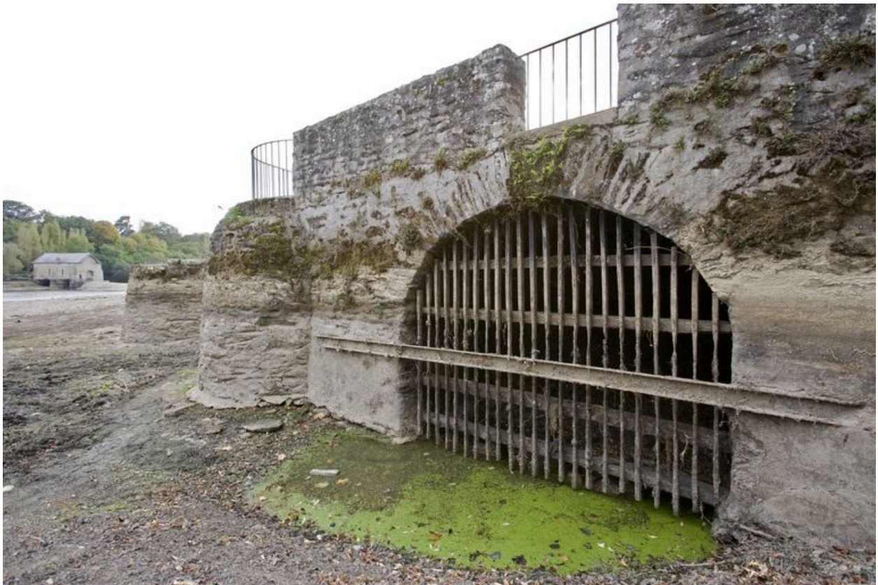
L'entrée du coursier de rive, pendant les écourues de 2009.
