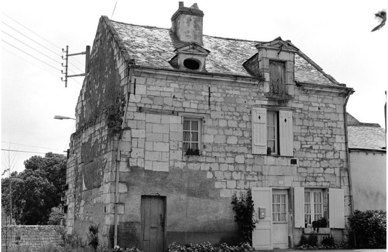
Vue générale de la maison conservant en élévation des vestiges du Gros pavillon, en 1979.
