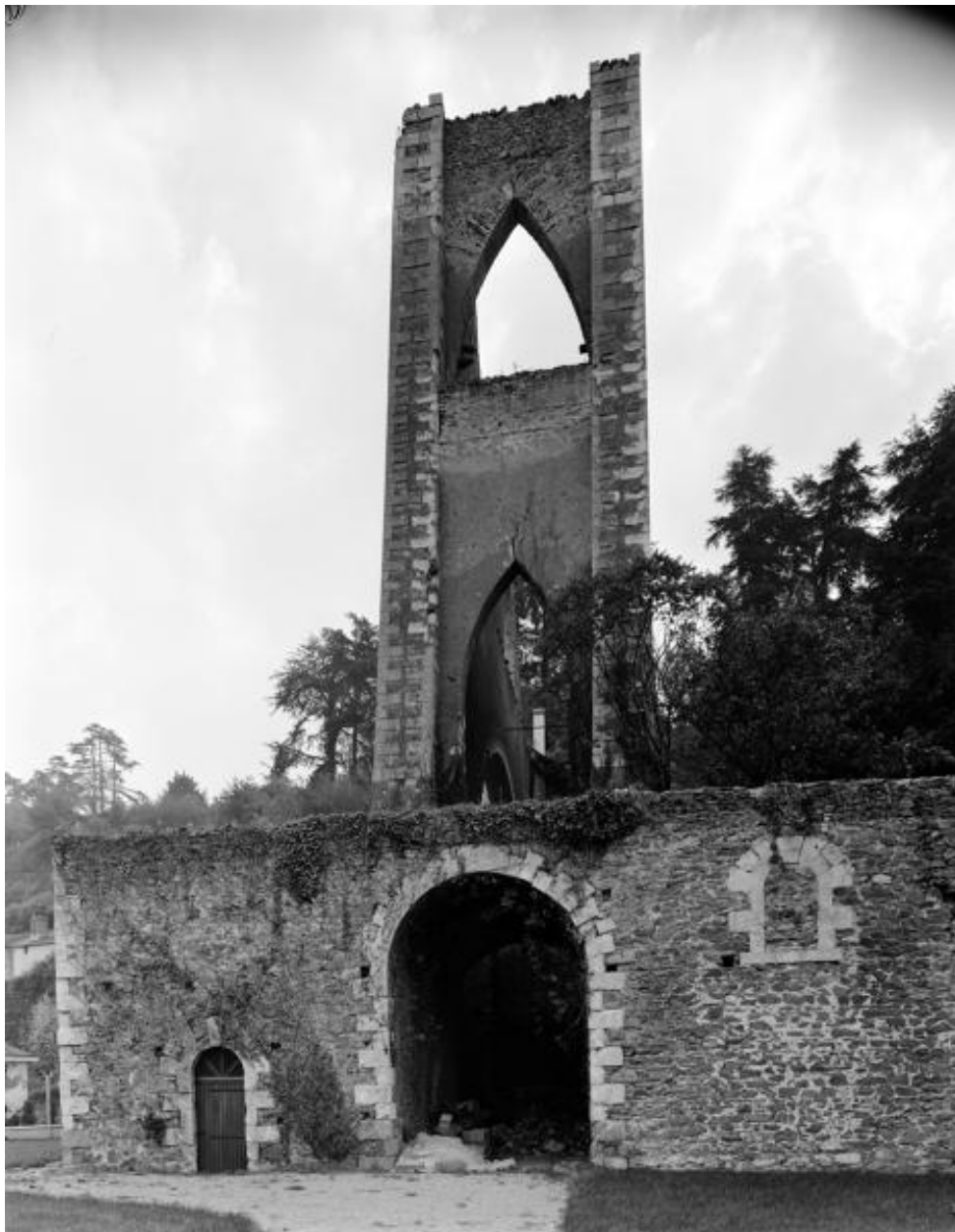
Vue de face du chevalement du puits de la Tranchée.
