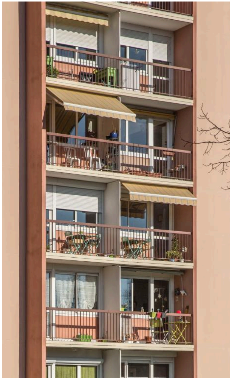
Loggia sur la façade sud d'une des tours du bord de l'Huisne.
