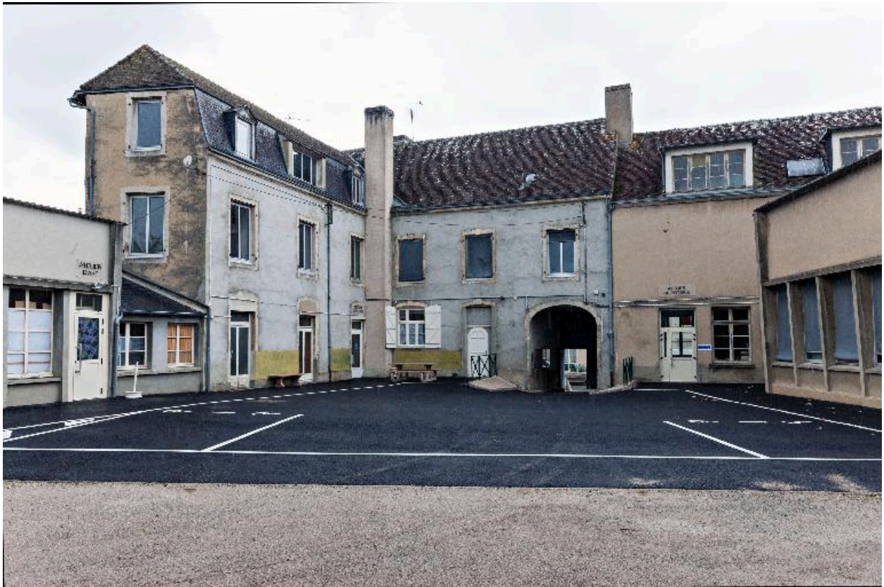
Elevations postérieures de la maison.
