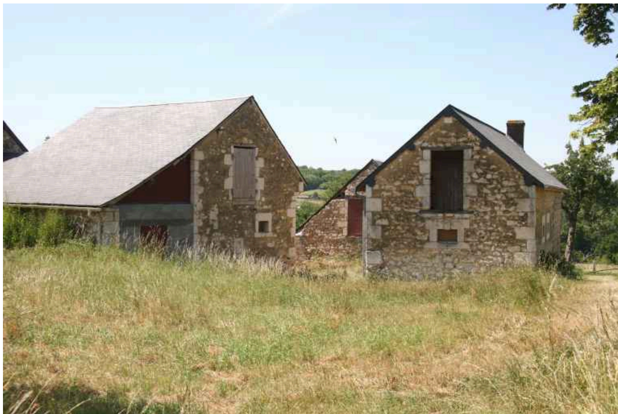
Entrée de la cour entre les dépendances.
