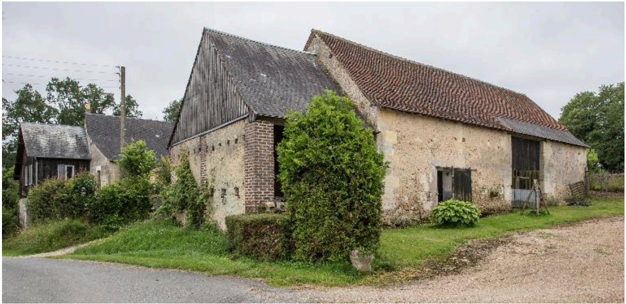
Grange-étable et hangar, de volume avec élévation sur cour.
