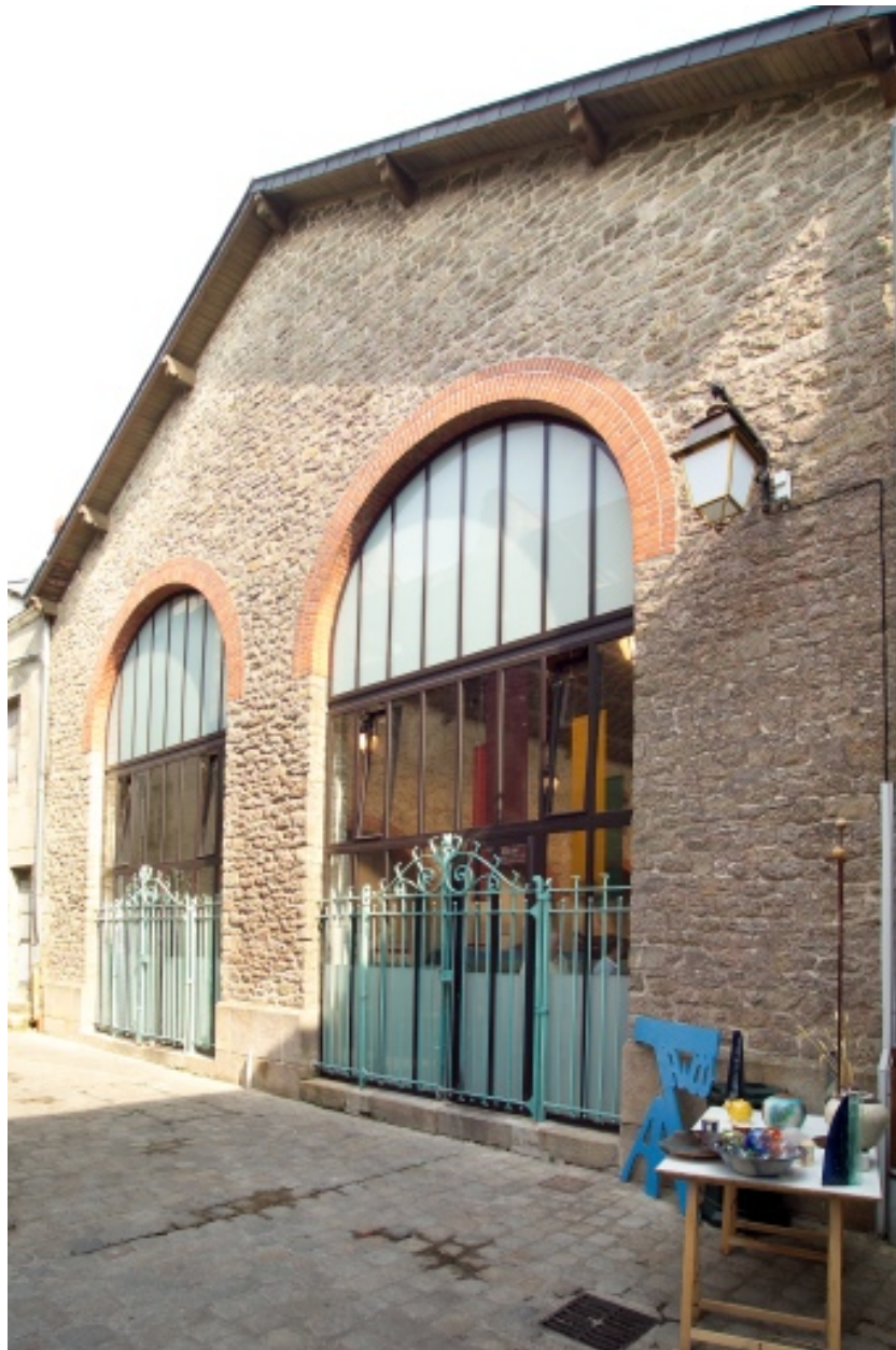
Vue de la façade arrière sud.
